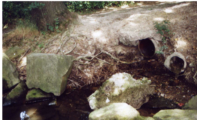
Verlegung der Einleitungsstelle und Renaturierung des Bachlaufes
