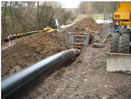
Einziehen des ca. 120 m langen PE-Rohres DN 400
